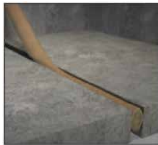
Avant que la conne ne sèche, introduire le bourrelet coupe-feu
