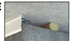
Bourrelet coupe feu avec couvre joint.
